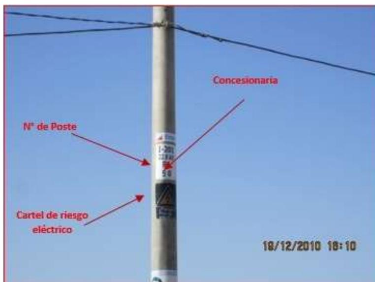
Señalización en la estructura de la línea de distribución eléctrica. Cada estructura a instalar deberá poseer su respectiva señalización de riesgo eléctrico, numeración de poste y número de la línea.
