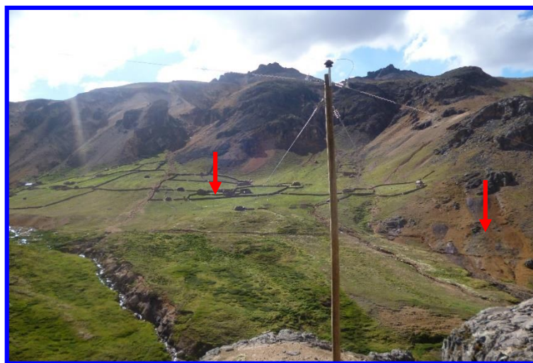
Fotografía N° 05.- Hacia el fondo de la vista se aprecia erosión de taludes de pendiente del cerro, por escurrecimiento superficial del agua de lluvia.
