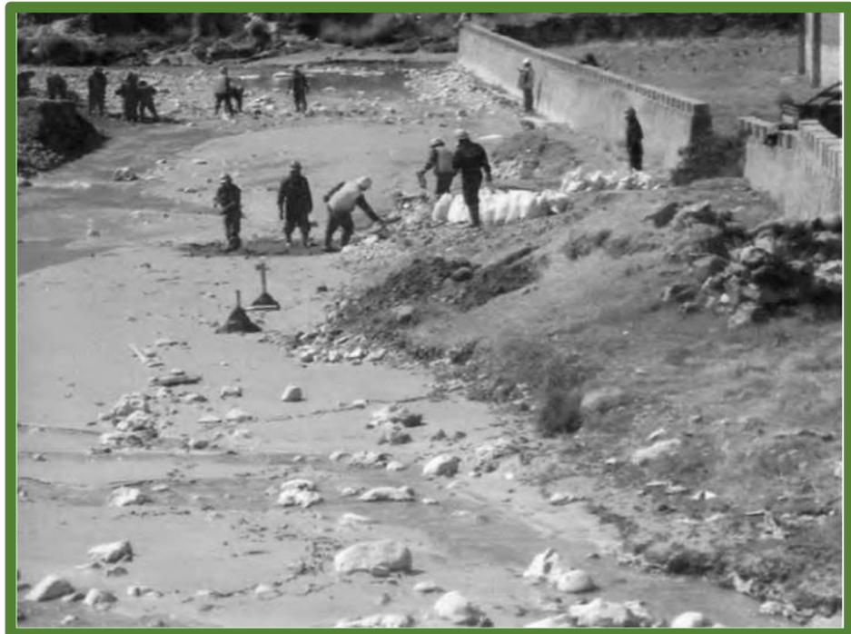
FOTOGRAFÍA N° 08: Trabajo de limpieza del cauce del río ejecutado por trabajadores de la mina (El Comercio 29-06-2010).
