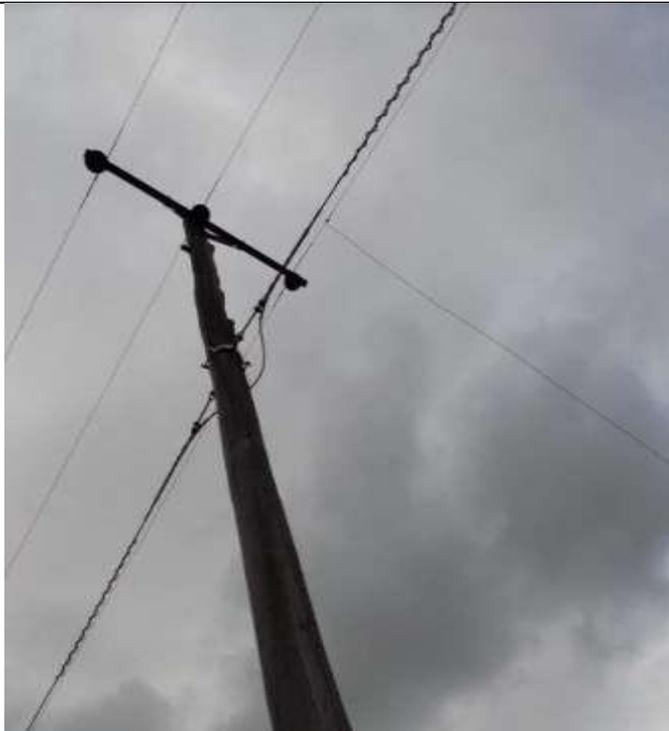
Estructura que corresponde al punto de derivación de la Línea Primaria.
