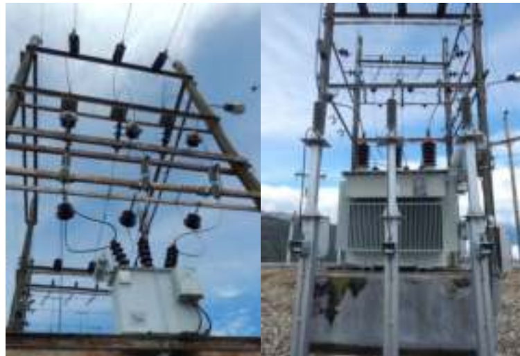
Gráfico N° 06. Equipos de protección lado 33 kV
