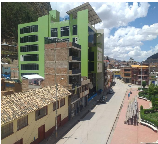
Vista del tramo donde se realizara el tendido de la línea primaria en 10 kv hasta la caseta de la Sub Estación Eléctrica, ubicado dentro de las instalaciones de la D.R.E.H.
