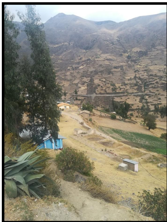
Foto N° 4: Ubicación del Transformador de la I.E. Alianza Andino
