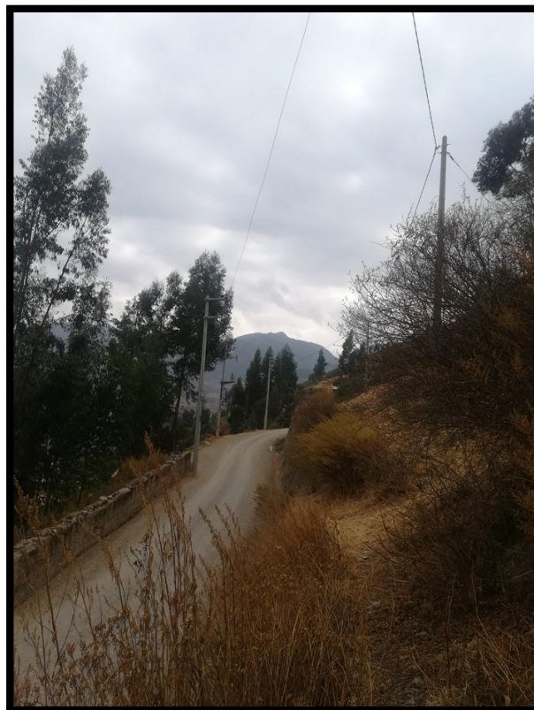
Fotografía N° 2: Terreno por donde se va a instalar la Red Eléctrica
