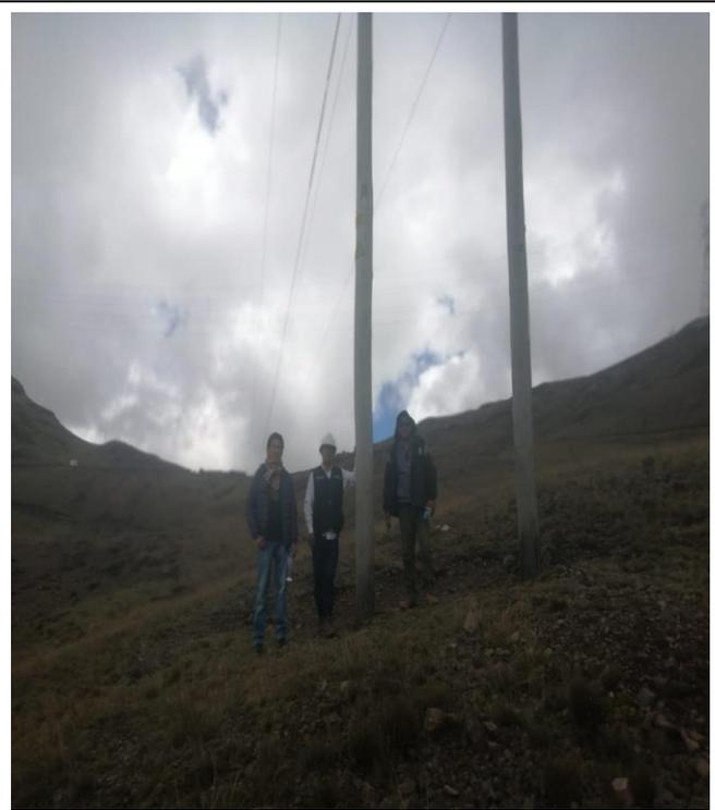
La línea y red primaria proyectada, tiene como punto de diseño en Media Tensión. Por tanto habiendo llegado a los **DOS POESTE** de media tensión con estructura N° 4AP02446, Alimentador A4022 de la SE Machahuay, red de MT 3Ø, 22.9 kV, propiedad de Electrocentro S.A. Se solicitó el punto de suministro y siendo factible para dicho proyecto.
