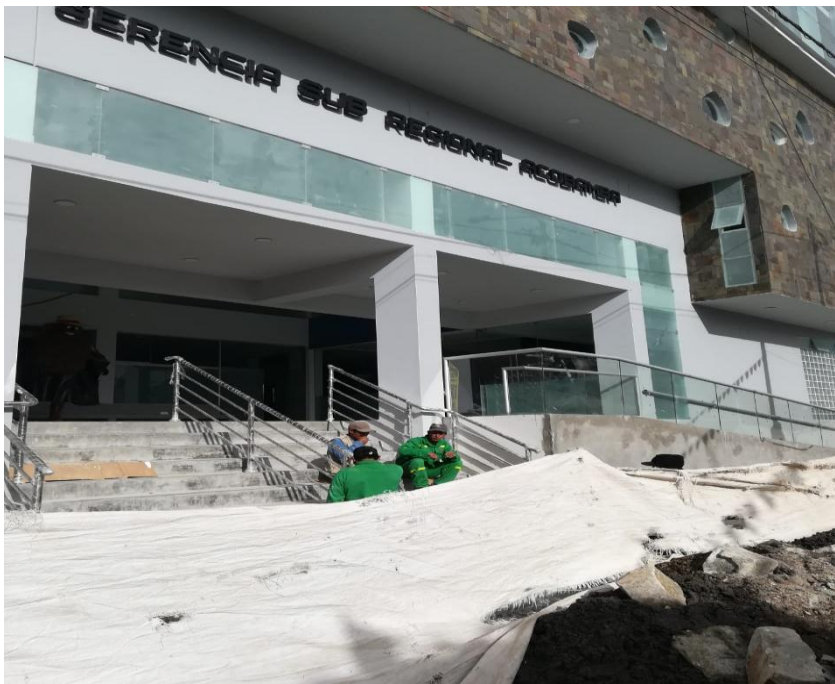
Foto N° 4: Ubicación de la Sede de la Gerencia Sub Regional de Acobamba
