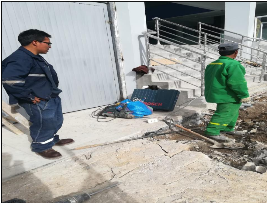
Fotografía N° 2: Terreno por donde se instalara la Red Eléctrica
