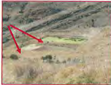
FOTOGRAFIA N° 135 Laguna de oxidación del distrito de Huasicancha
