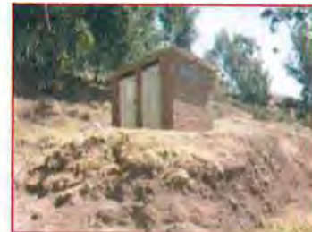
FOTOGRAFIA N°137 Letrinas del distrito de Chacapampa
