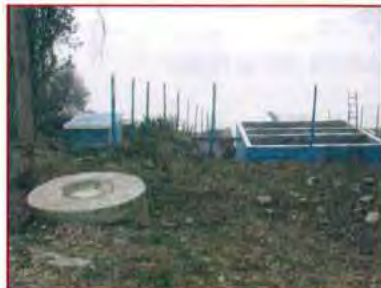
FOTOGRAFIA N° 152 Planta de tratamiento de agua residual modelo IMHOFF.
