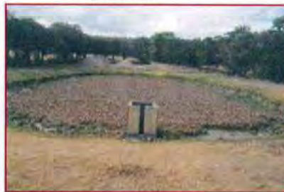
FOTOGRAFIA N° 178 Pozas de oxidación en Villa Florida eutrofizadas
