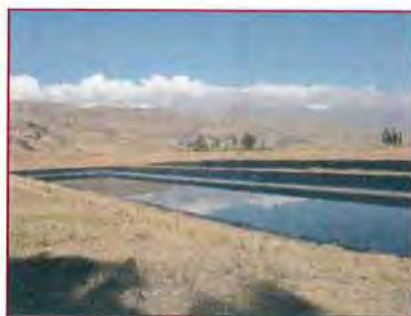
FOTOGRAFIA N° 79 Laguna de oxidación del distrito de Pucara.
