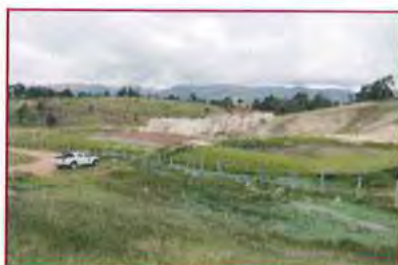
FOTOGRAFIA N° 181 Pozas de oxidación en Pampamarca
