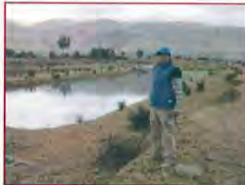
FOTOGRAFIA N° 74 Laguna de oxidación, sin revestimiento de geomembrana, del centro poblado de Huamanmarca.
