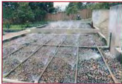
FOTOGRAFIA N° 176 PTAR ALAMEDA (EPSASA-Huanta)
