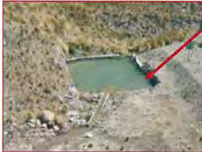
FOTOGRAFIA N° 120 Agua procedente de filtraciones subterráneas.
