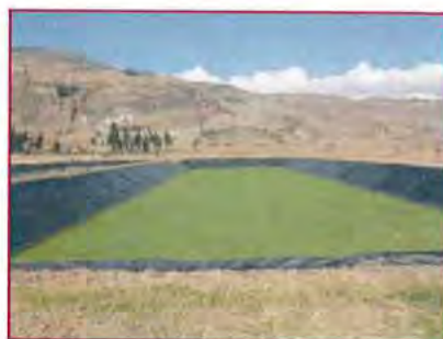
FOTOGRAFIA N° 80 Laguna de oxidación con falta de mantenimiento.
