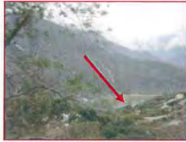
FOTOGRAFIA N° 149 Central Hidroeléctrica del Mantaro.
