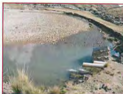
FOTOGRAFIA N° 184 Vertimiento de aguas residuales domésticas de la PTAR de Huachucolpa
