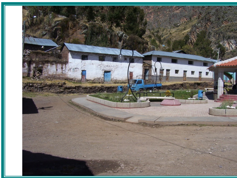
Fotografía. -Características de Vivienda en Acobambilla. Material predominante el adobe con techo de calamina a dos aguas.
