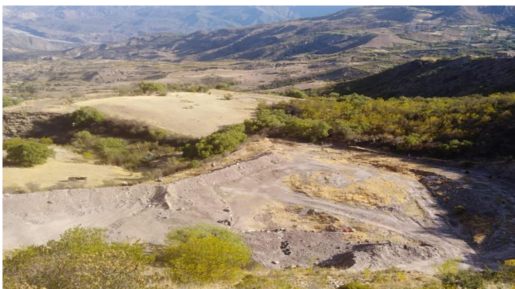
Foto N° 04 vista panorámica de la celda habilitada – Chilcapucro
