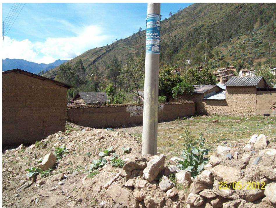
Fotografía-6: Viviendas típicas en el distrito de Colcabamba
