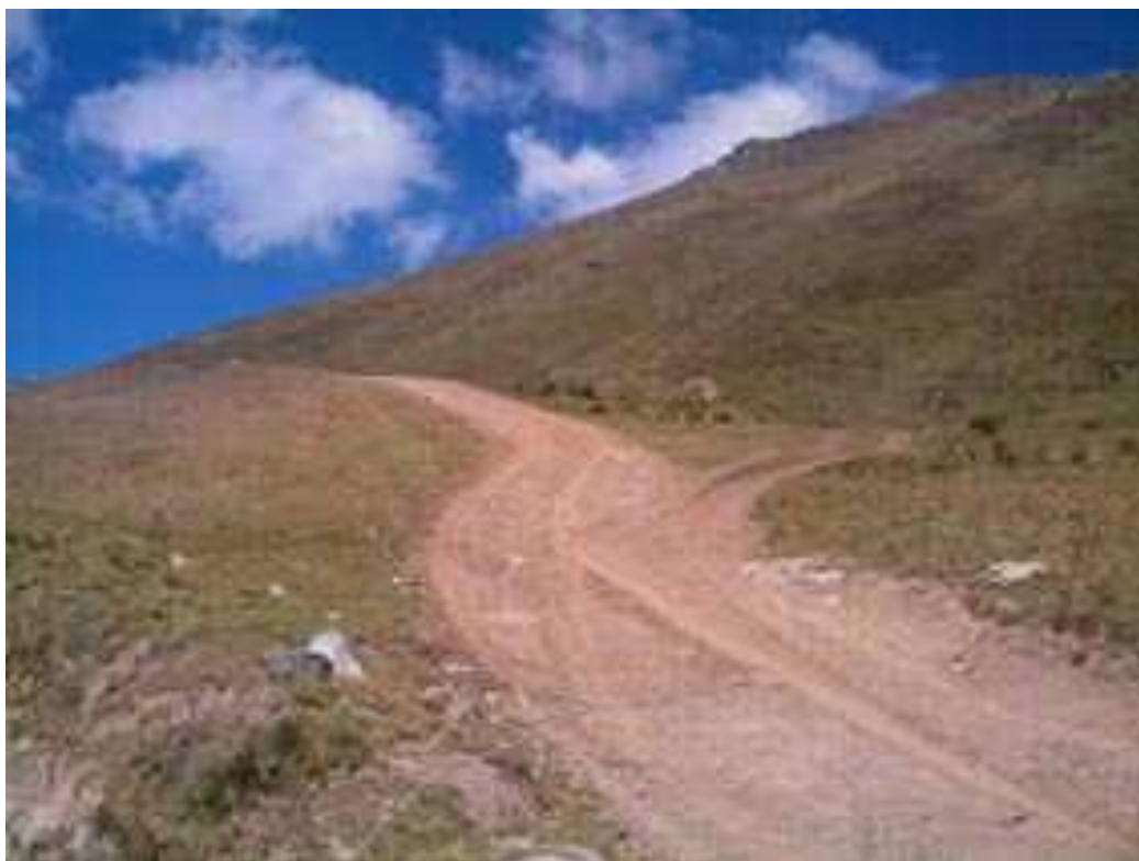
Fotografía -10: Detalle de la trocha afirmada que conduce de Pampas a Colcabamba
