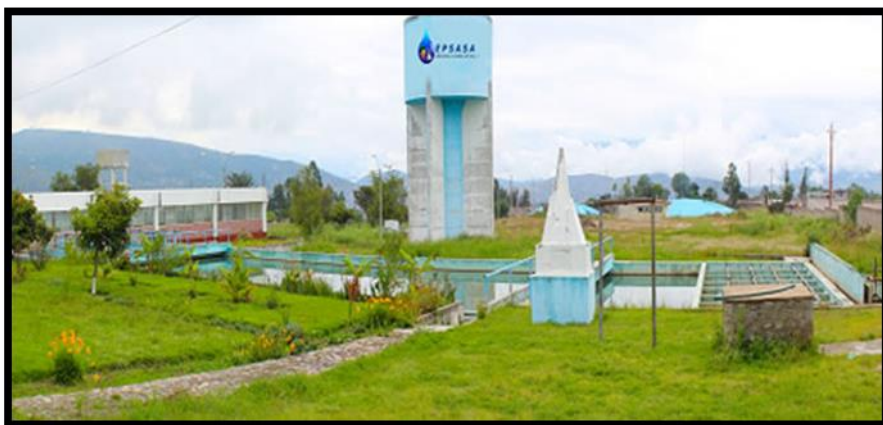
Foto N° 60. Planta de Tratamiento de Agua Potable de Ayacucho
