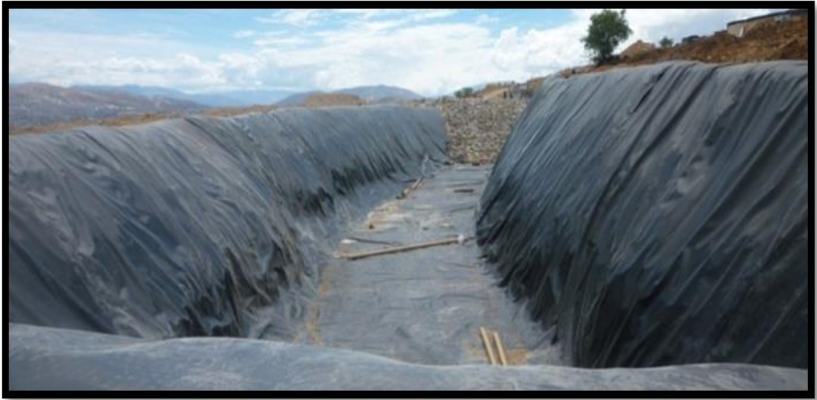
Foto N° 76. Revestimiento con Geo Membrana al botadero controlado de Huamanga.
