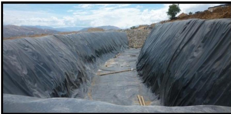
Foto N° 70. Revestimiento con Geo Membrana al botadero controlado de Huamanga.
