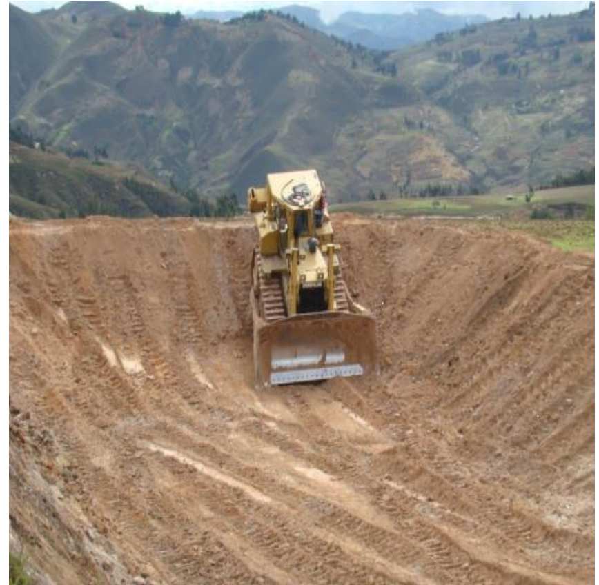
CONSTRUCCIÓN VASO COLECTOR – PARA RIEGO
