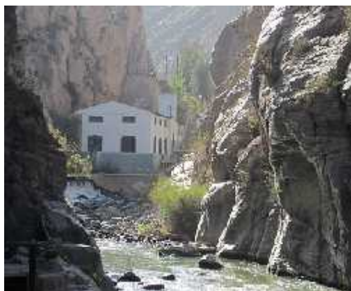
Vista de la Central Charcani II
