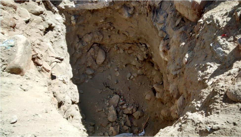
Foto 5 – Excavación de unos 2.5 metros de profundidad de cercanía al lecho del río; demuestra la estratigrafía del suelo en la zona.
