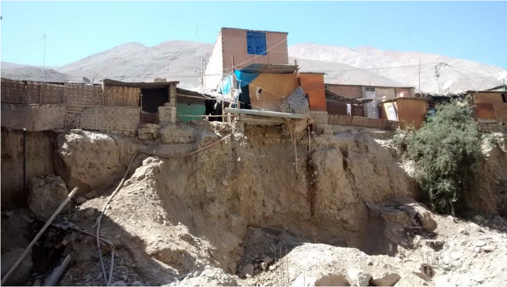
Foto 3 – Viviendas en cercanía al lecho del río amenazadas por la erosión hídrica
