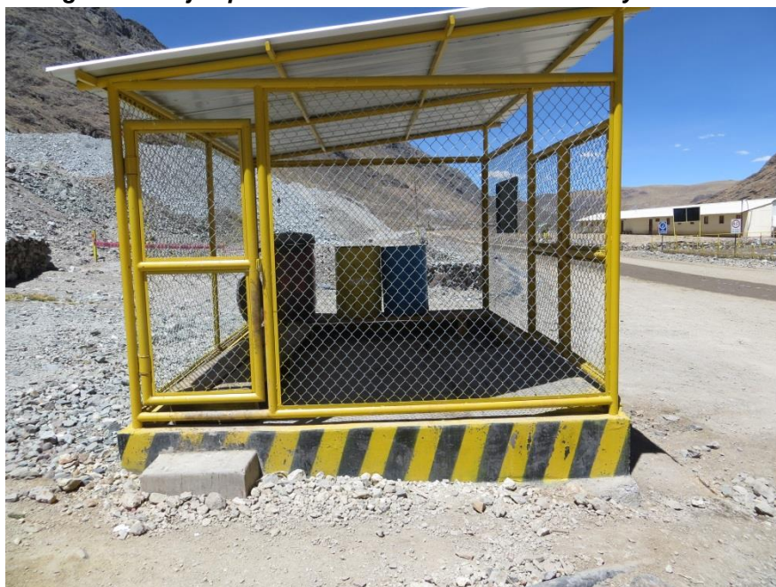
Imagen N° 1: Ejemplo de un almacén de combustible y lubricantes
