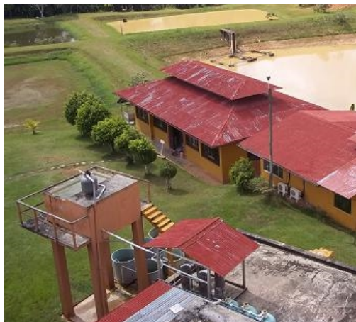
Foto N° 10: Sistema de Tiramiento de agua al Hatchery
