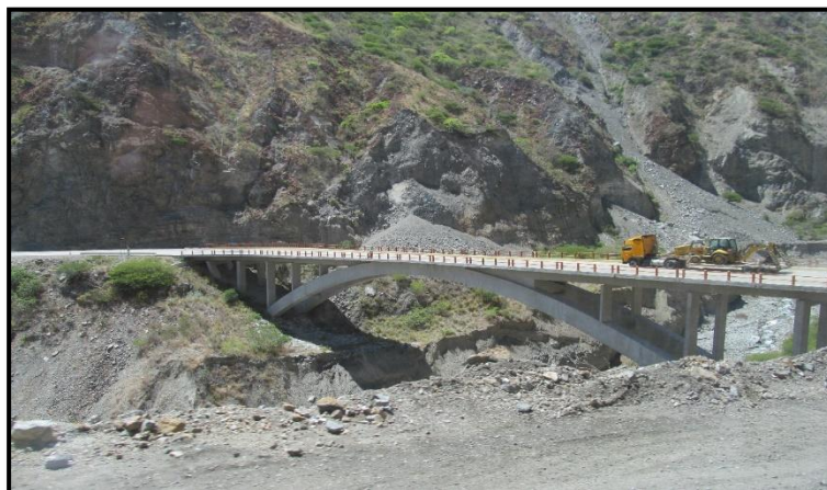
Puente Quebrada Honda, distrito de Curahuasi.
