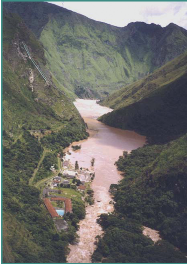
Figura 26: La central hidroeléctrica de Machu Picchu inundada por el río Vilcanota a causa del aluvión del 27 de febrero que barrió el Vilcanota ríos debajo de la central.
