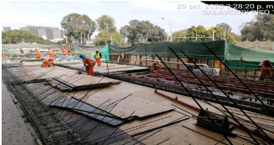
Vista encofrado de fondo de losa aligerada, para el techo del Sótano 1 de la Torre Salaverry.
