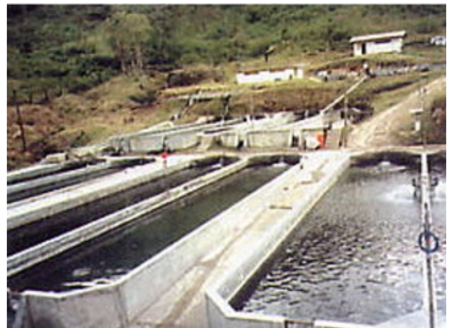
Estanque de concreto
