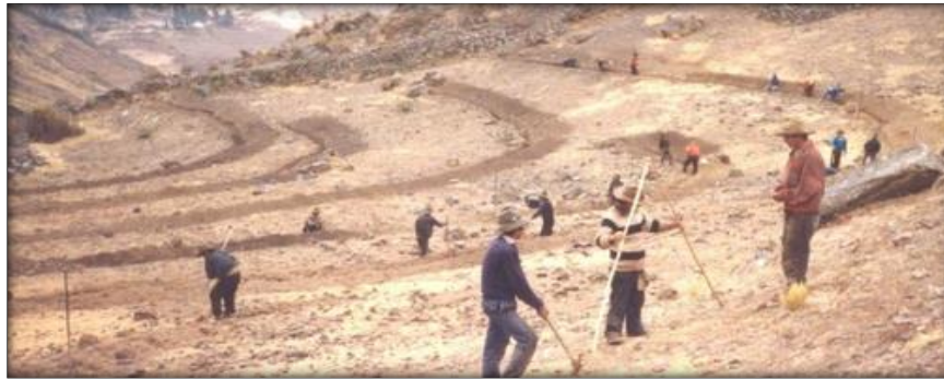
Figura N° 34: Trazo y marcación de terrazas
