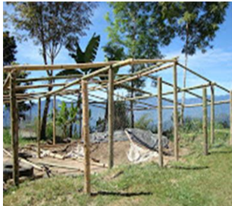
Figura N° 3: Armado de estructura de madera
