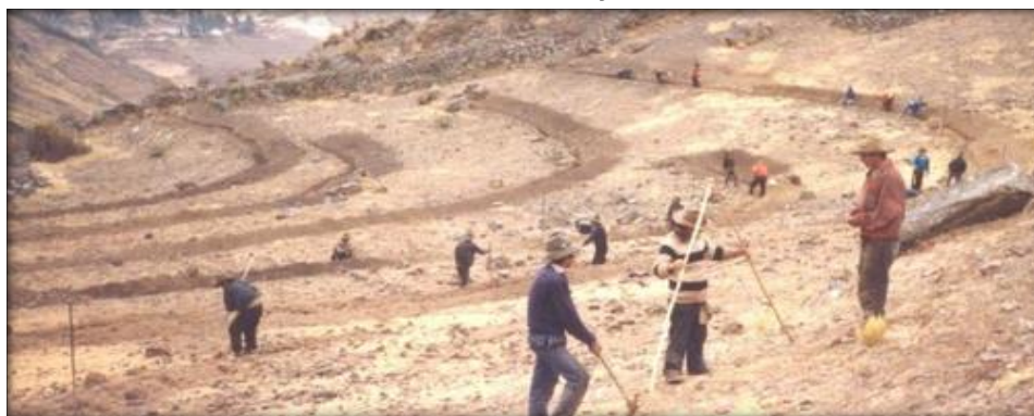
FIGURA N° 044: Trazo y marcación de terrazas
