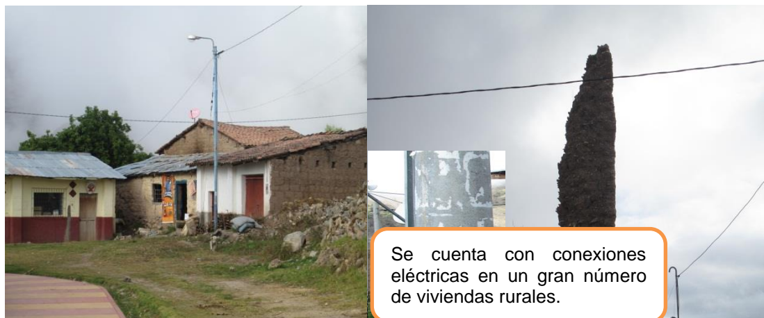
Fotografía 06: Energía eléctrica en el sector rural
