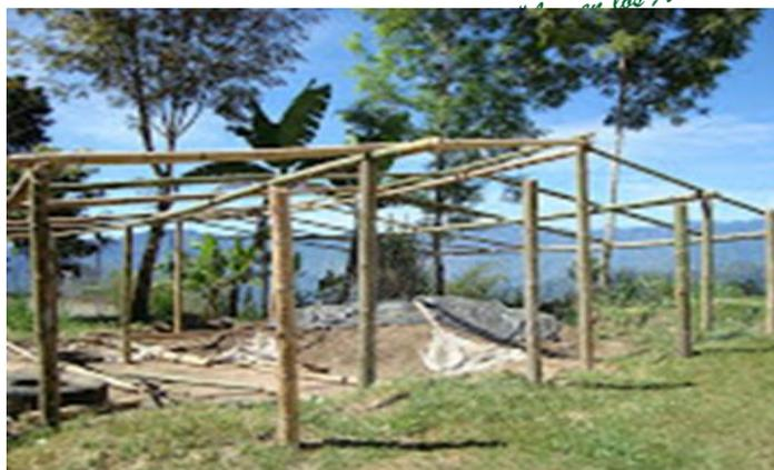
**15. Techado:** Concluida con el armado de la estructura de madera se procede con el techado con calamina de 1.80 x 0.80 de 0.24 mm. de espesor fijando con clavos de calamina con cabeza.
