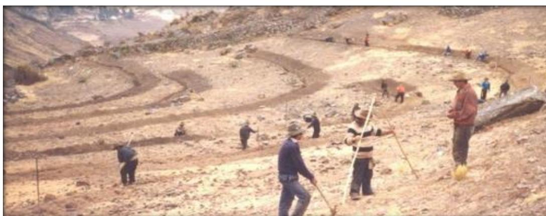
**13. Construcción de terrazas de formación lenta:** En la construcción de las terrazas de formación lenta, se recomienda realizar la excavación del terreno para la cimentación y el enrocado de las piedras y champas utilizando la mano de obra local, cuya medición se da en m<sup>3</sup>.
