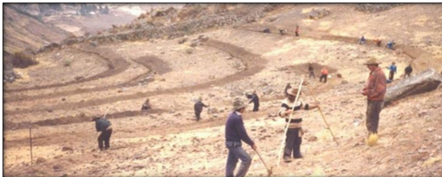
FOTOGRAFÍA N° 11: TRAZO Y MARCACIÓN DE TERRAZAS
