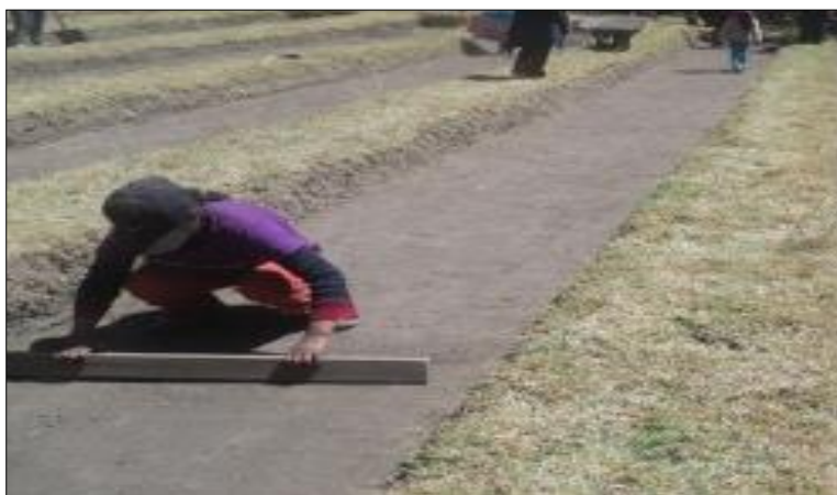
Figura Nº 14: Nivelación de camas
