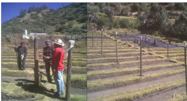
Figura Nº 18: Construcción de tinglado
