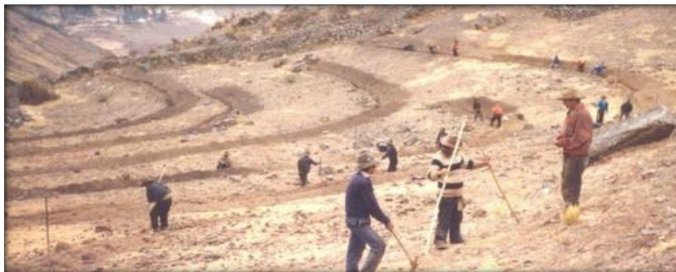
Figura N° 32: Trazo y marcación de terrazas
