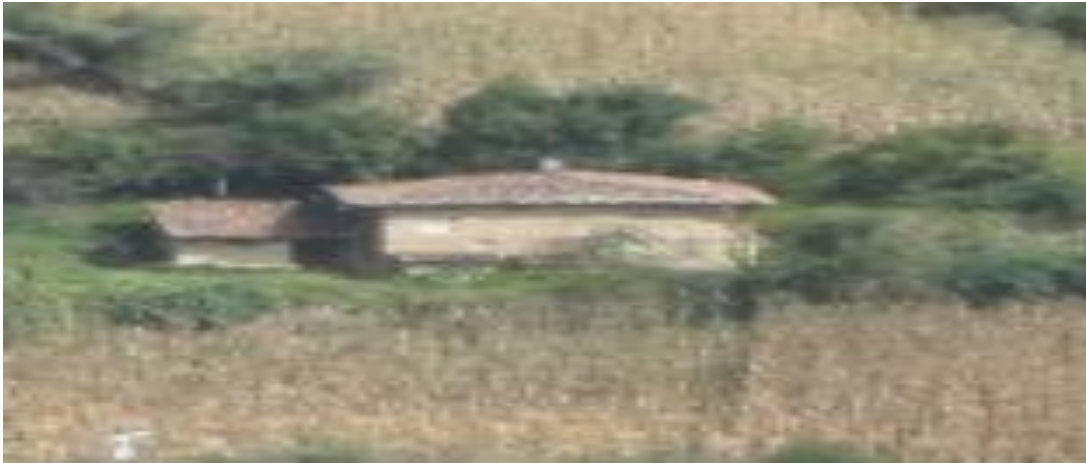
Foto N°03 Construcción de vivienda
