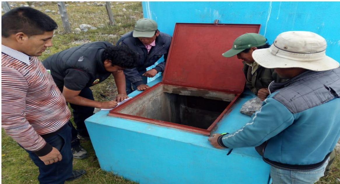
**FOTO 27: Supervisión y asistencia técnica de caja rompe presión**
