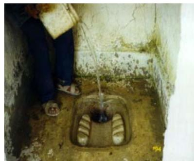
Una observación importante es que algunos usuarios para la evacuación de los desechos sólidos, ya no usan el tradicional “balde de agua”, sino que han adecuado una válvula (grifo) en la pared de la letrina, la misma que evacua automáticamente las excretas hacia el pozo.
