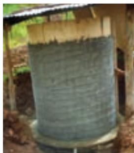
Armado de refuerzo con encofrado
