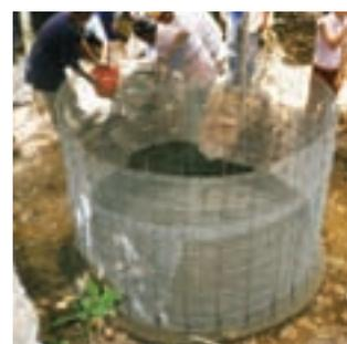
Armado de refuerzo sin encofrado
