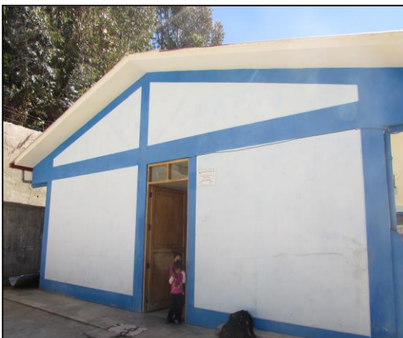
Foto 03: Puesto de salud Patapata
