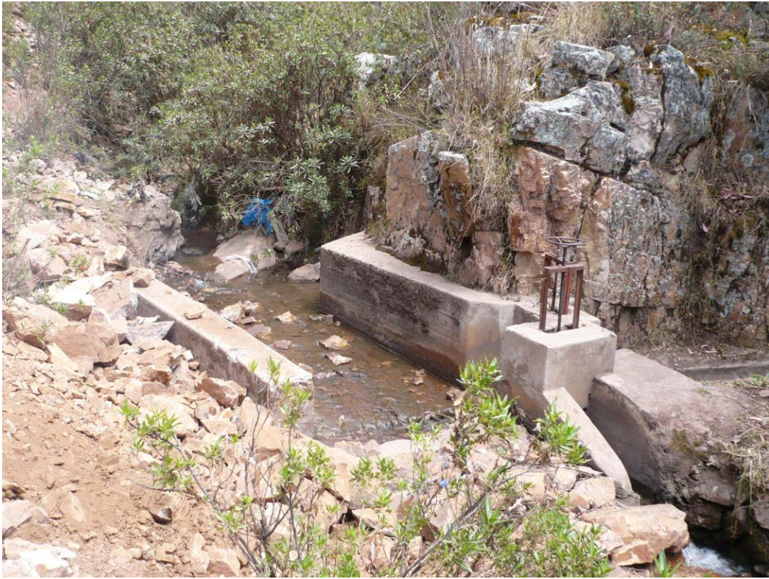
CAPTACION EXISTENTE (Sector de Pumahuasi)
