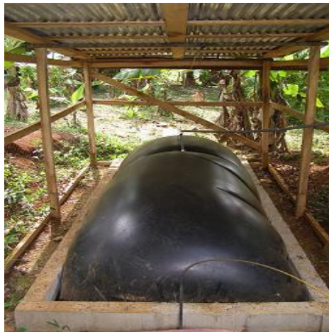
FOTO Nº 01 BIODIGESTOR DE MANGA TERMINADO
