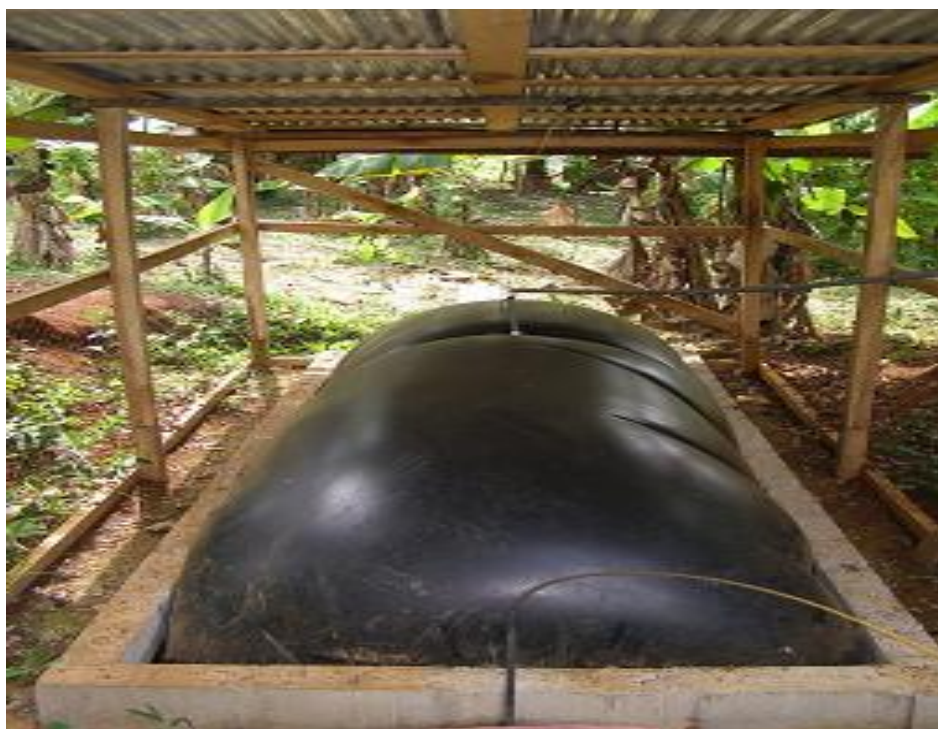
FOTO N° 01 BIODIGESTOR DE MANGA TERMINADO
