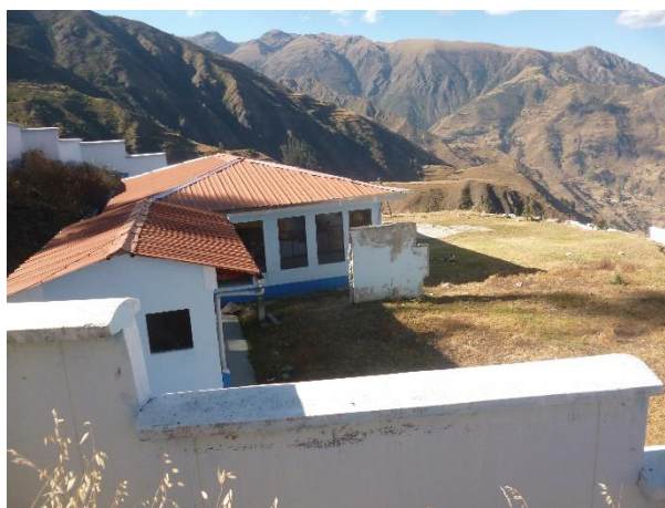
Foto 04: Puesto de salud instalada en la comunidad
