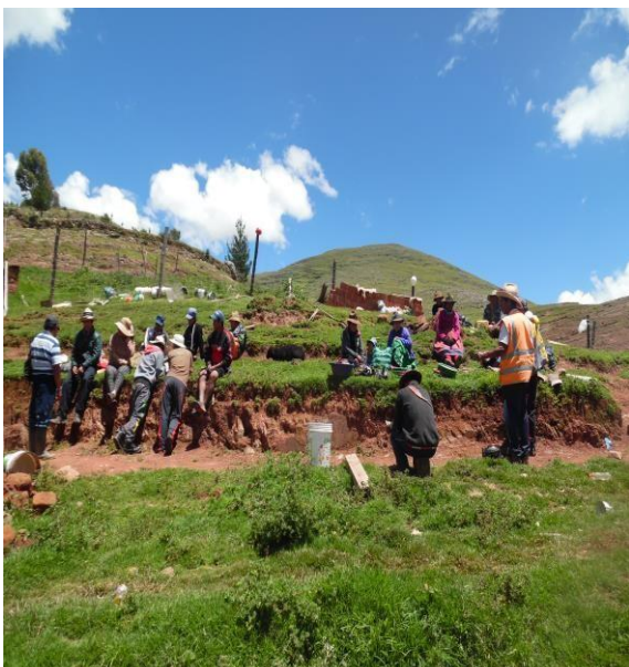
Faena de protección de caminos y muros
