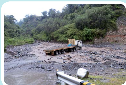
Huayco en la carretera Abancay – Lima, quebrada Ñacchero (PACC Perú)
