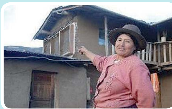
Calefactor solar o "muro trombe" instalado en el distrito de Pacucha Andahuaylas. (Sencico)
