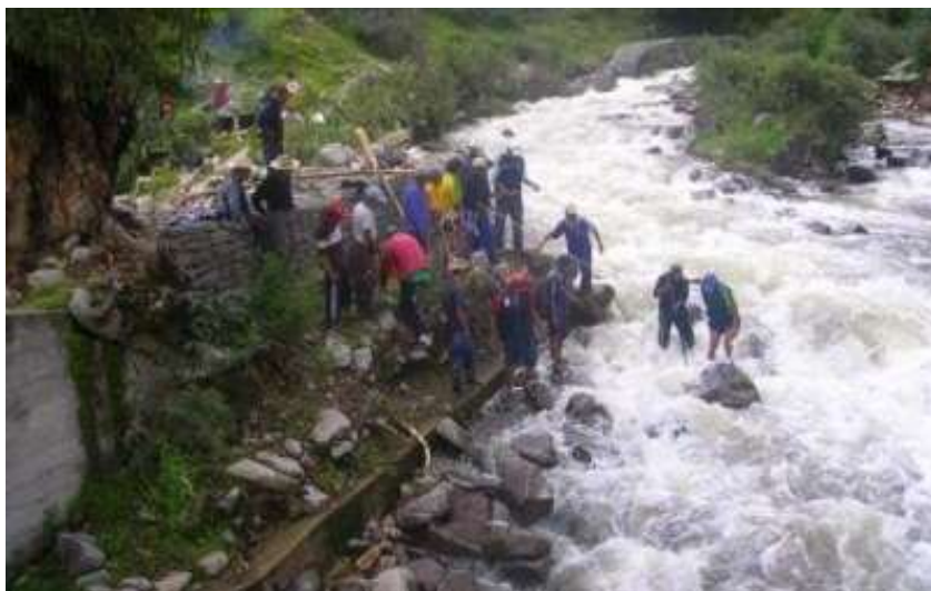
Foto 25 Pobladores de Totora-Oropesa tratando de reforzar defensas ribereñas en la margen derecha del río Oropesa (foto por cortesía del GORE Apurímac, enero del 2004).
