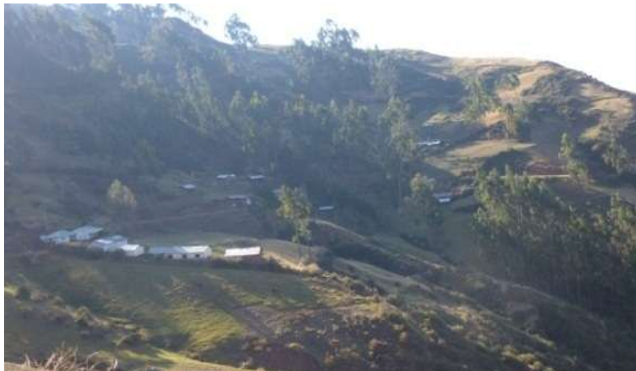
Foto 11. Viviendas localizadas en el cuerpo del antiguo deslizamiento de Trujahuasi (en el distrito de Kaquiabamba, provincia de Andahuaylas). La reactivación afectaría 14 viviendas.
