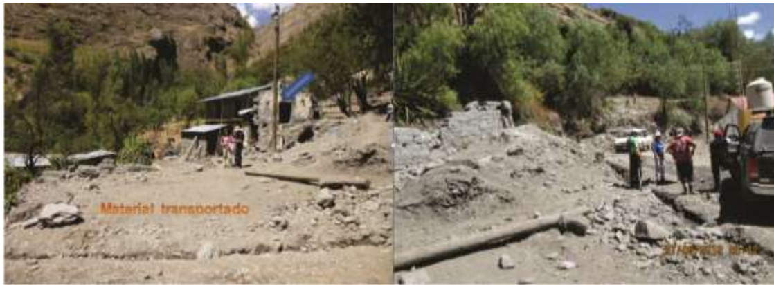
Fotos 12 y 13. El flujo de Paccayura (distrito de Progreso, provincia de Grau) impactó con varias viviendas ubicadas en su cauce.
