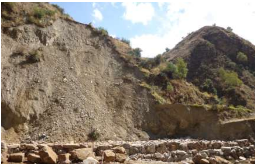
Foto 2. Derrumbe que originó la ruptura de la base de la carretera Cusco-Abancay a la altura del puente Calicanto (distrito de Haqira, provincia de Cotabambas).
