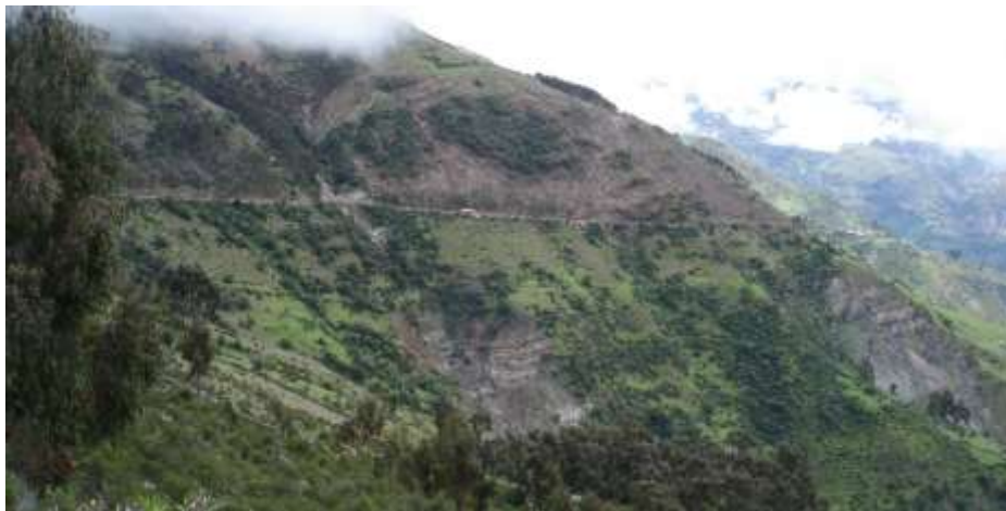
Foto 24. Erosión de laderas del cerro Chipana a la altura de Huaijerosi (distrito de Huaccana, provincia de Andahuaylas).
