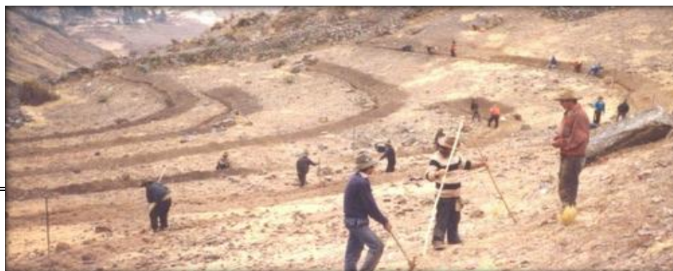
FIGURA N° 040: Trazo y marcación de terrazas
