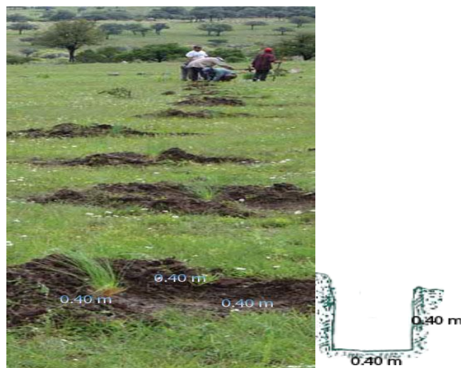
Figura N°02: Apertura de hoyos
