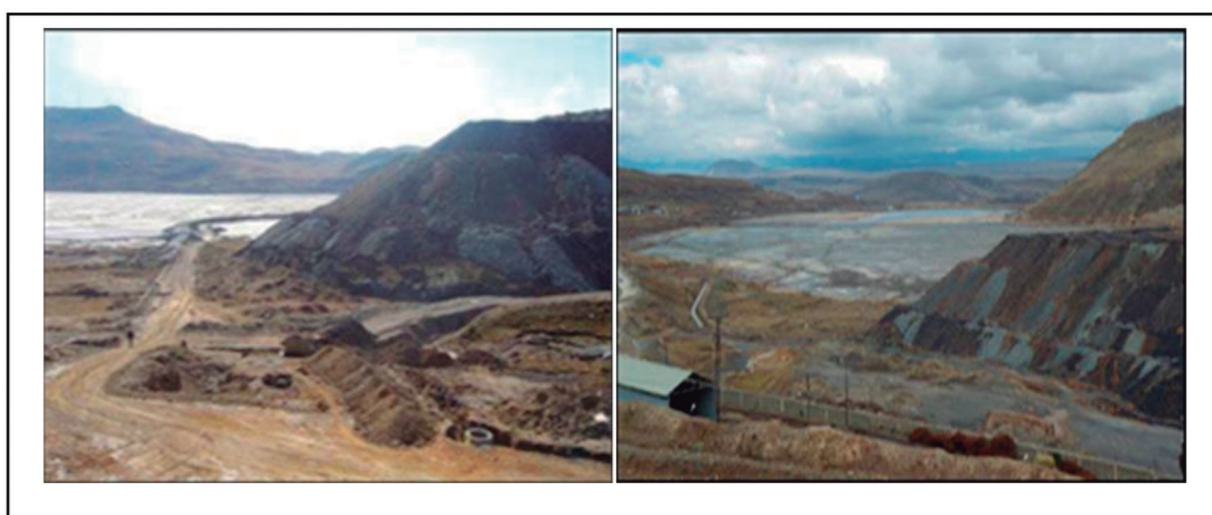
Figura 8. Estado de la Desmontera Excélsior
