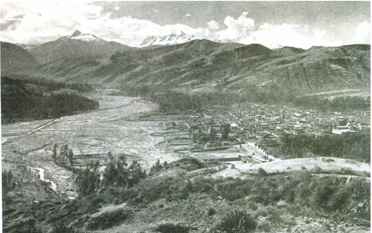
Huaraz en 1948 vista desde el oeste con la Zona Aluviónica (Heim, 1948, lám. 148)
