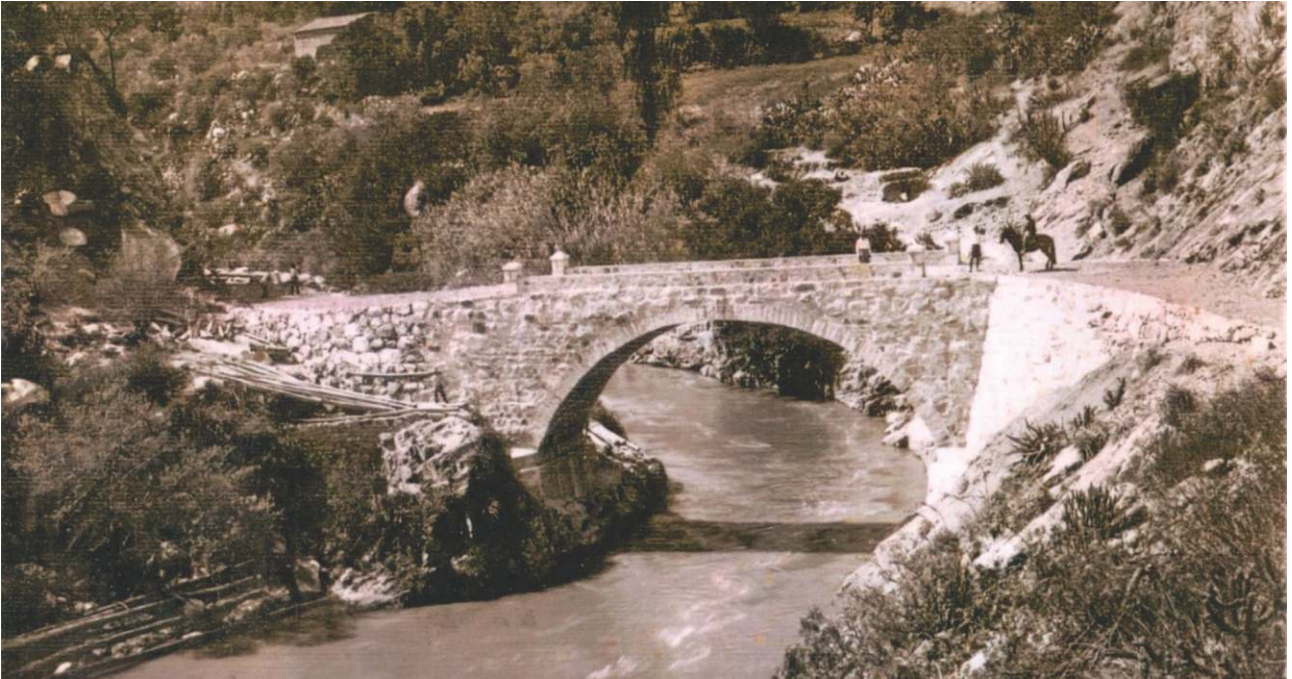
Puente Pomachaca sobre el río Santa, entre Caraz y el lado de la Cordillera Negra por La Carbonera, el día de su inauguración en 1936. Desapareció en el Aluvión.
