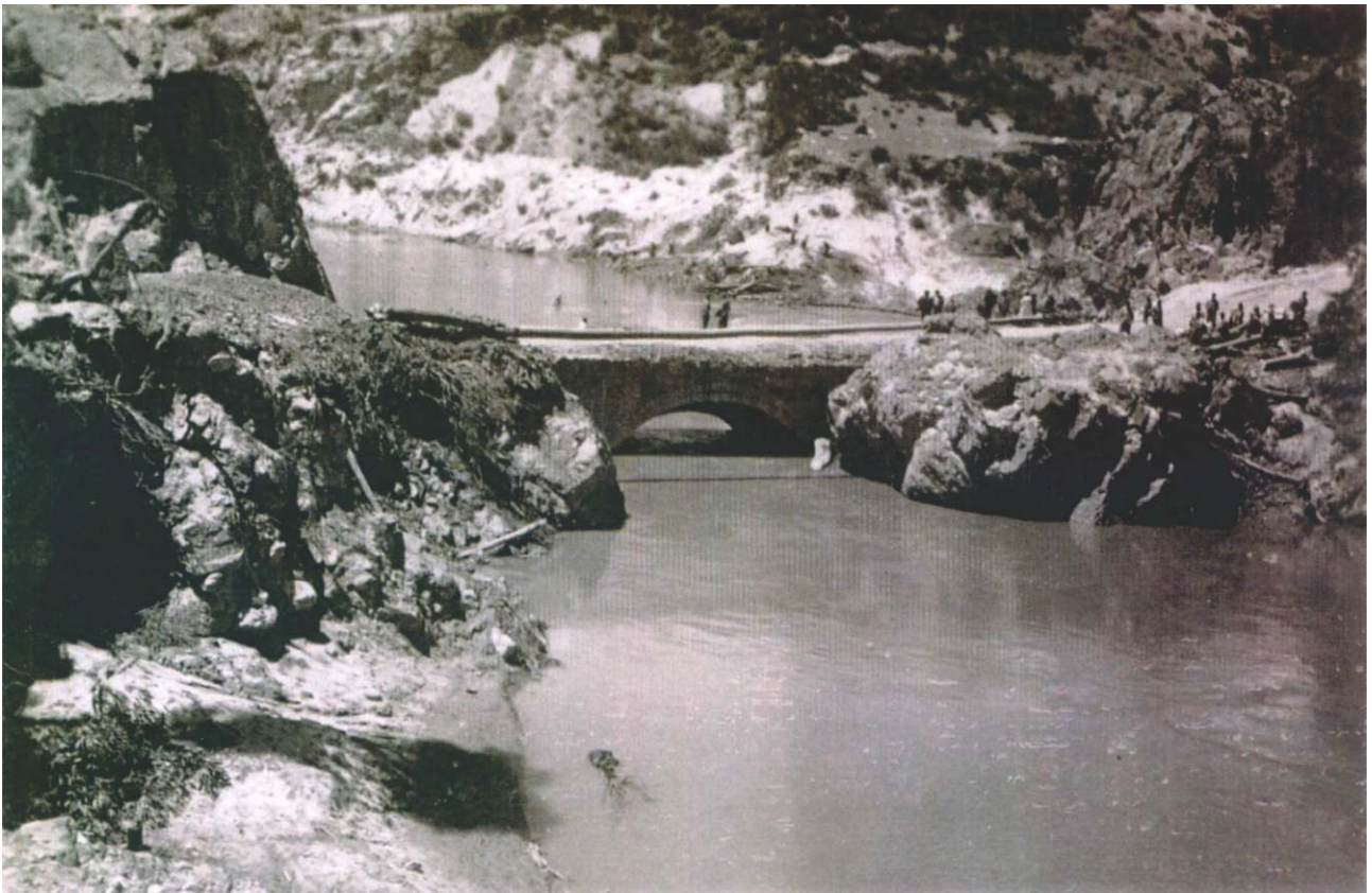
Puente San Jerónimo después del Aluvión. Atrás se nota una zona blanca en la falda del cerro hasta donde llegaron las aguas temporalmente represadas del río Santa.
