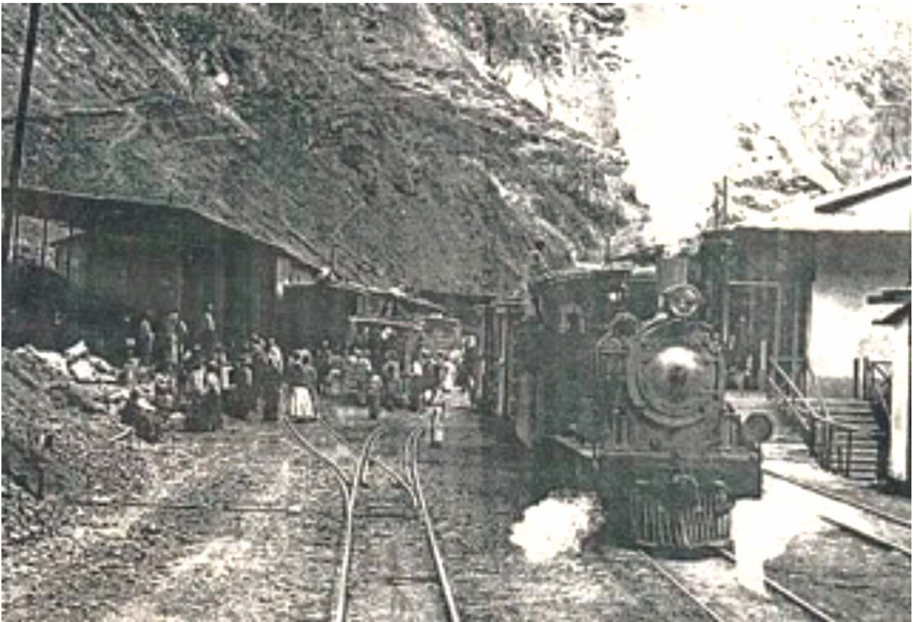
La vía del tren de Chimbote a Huallanca fue destruida por 80 km, hasta Tablones
