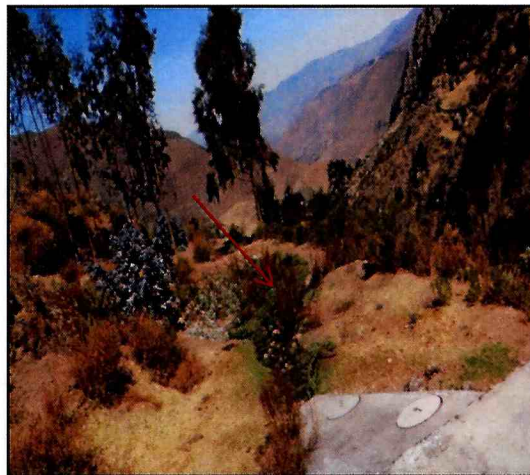
Fotografía N°02: 137592FCVD01; Vertimiento de aguas provenientes de la Planta de tratamiento del Centro Poblado de Huambo hacia la Qda. Socopuquio, que tributa por la margen derecha al río Fortaleza.
