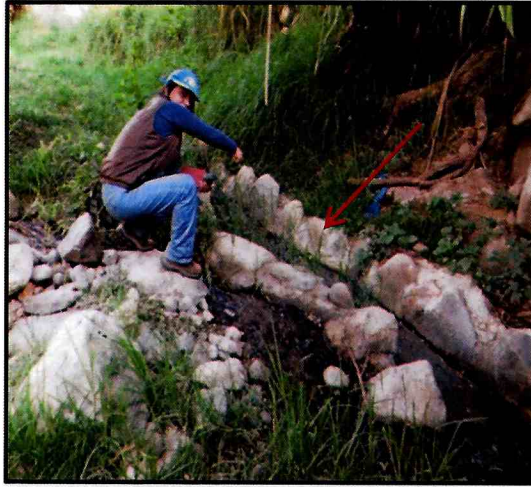
Fotografía N° 09: 137592FCVD05, Canal rústico que conduce las aguas residuales domésticas tratadas de la ciudad de Raquia y de San José de Apac hacia la margen izquierda del río Fortaleza.
