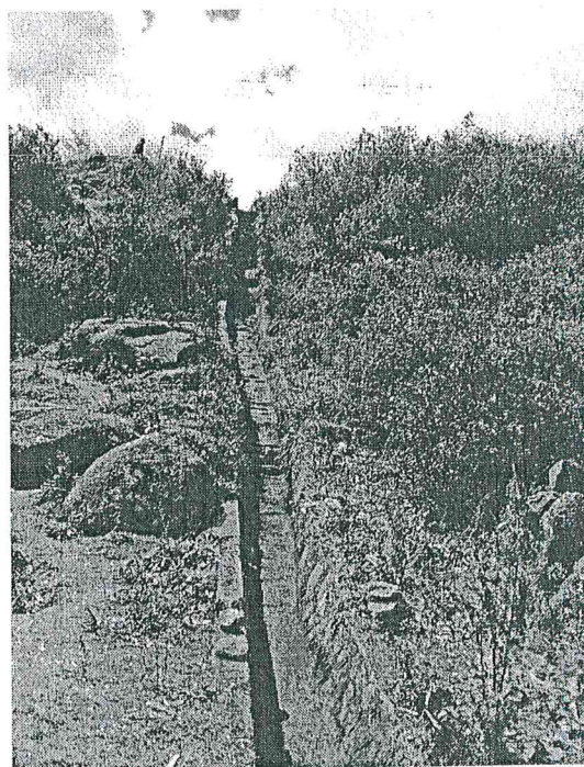
FOTO N° 2.-Salchuchas absorbentes y obstrucción del cauce con tierra
