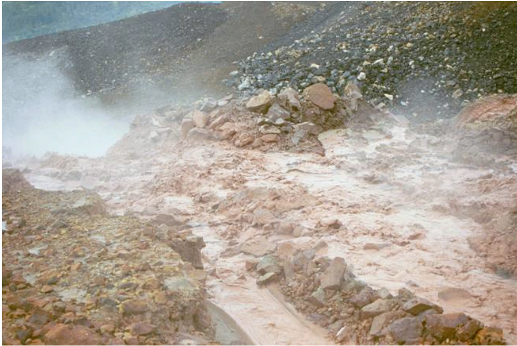
Botadero minero en Porgera, Papua Nueva Guinea. La minería deja enormes cantidades de material contaminado y un paisaje feo (fotografía: Earthworks)
